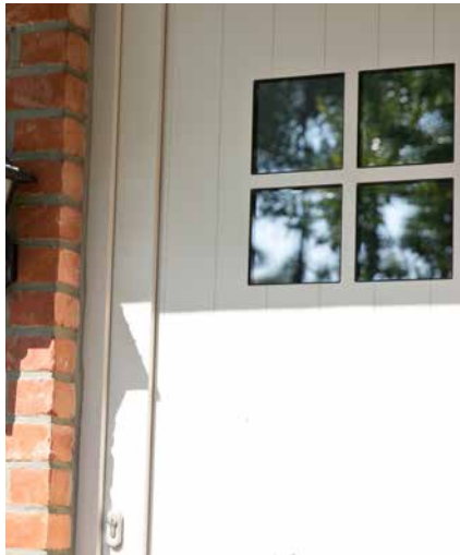
1 Kader 2 Vleugel 3 Vulling (paneel of glas)
